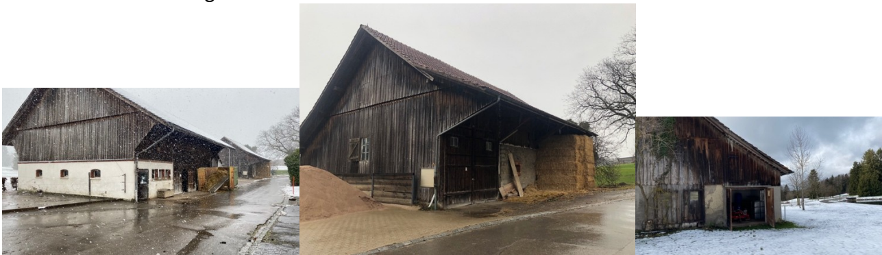
S Scheune 11. Abschlag
